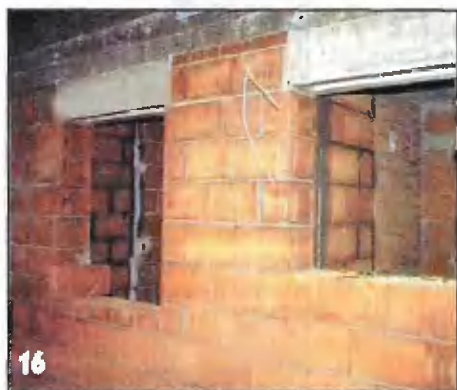
Наружное освещение требует собственных элементов подключения.
