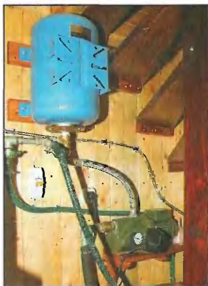
Емкость для воды и насосную станцию удалось разместить под весьма компактной лестницей.
