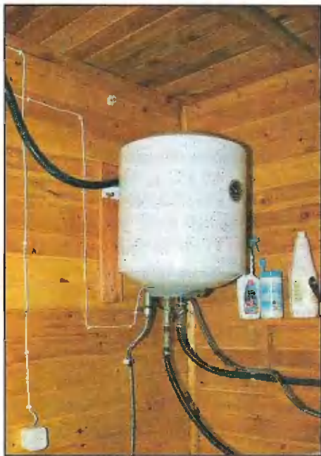
Горячей водой систему обеспечивает накопительный электрический водонагреватель фирмы «Ariston» емкостью 50 л.
