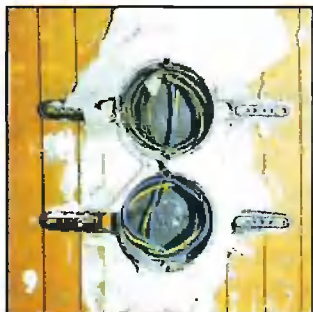
9 Введённые в розетку провода закрепляют гипсом.
