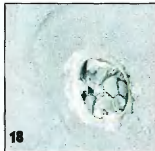
При оштукатуривании стены закладные монтажные коробки можно набить скомканной бумагой или...
