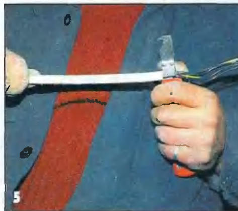
У кабелей других видов специальным ножом удаляют изоляцию до ввода в закладную коробку розетки.
