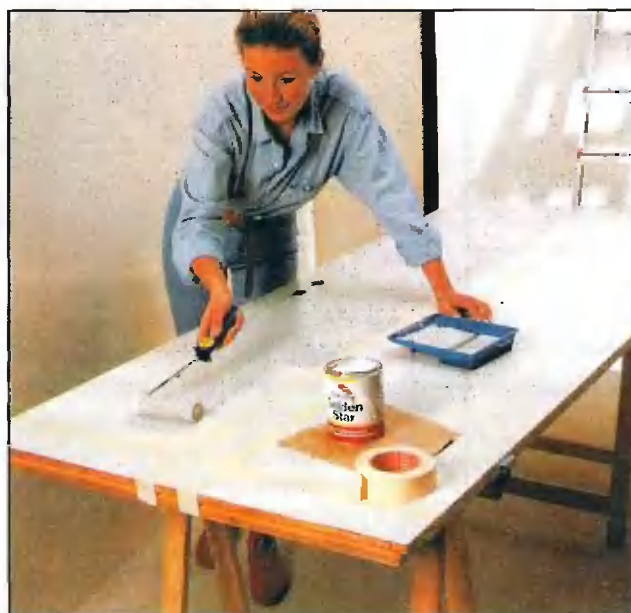
Перед окраской первым цветом нерábочие участки тщательно закрывают малярной лентой. Краску наносят поролоновым валиком, а не кистью — это ускоряет работу и обеспечивает равномерность покрытия.
