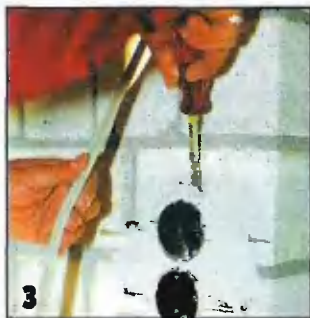
3 Замоноличивают закладные коробки розеток гипсом, а позднее прочищают отвёрткой кабельный ввод.
