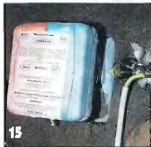
15 Для заземления используют оцинкованную или медную трубку.
