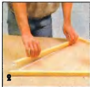
2 Между фанерными листами обшивки этой полки вклеивают бруски. Образовавшуюся полость используют для прокладки электропроводки к галогенным светильникам.
