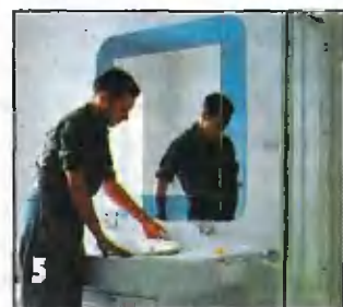
После облицовки шкафчика монтируют раковину.
