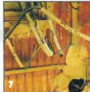
7 На каждый провод надевают изоляционную трубку с маркировкой.
