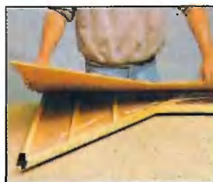
4 В промежуточных брусках пропиливают пазы для проводов.
