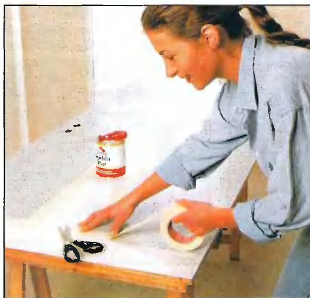
Только после того, как краска высохнет, можно наносить краску другого цвета. Если наклеить малярную ленту слишком рано, вся недосохшая краска прилипнет к ней. Белая полоса в основании двери продолжается и на стенах, как и вертикальная срединная полоса.
