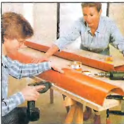
Чтобы полуколонна не гнулась, между продольными краями вставляют и крепят полосу ДСП. Позднее за неё колонну подвешивают на стену.
