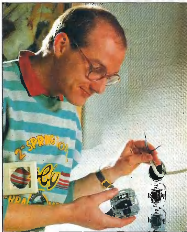
У кабелей других видов специальным ножом удаляют изоляцию до ввода в закладную коробку розетки.
