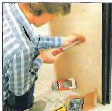
Небольшие крюки надёжно удержат полуколонны на стене. Они должны выступать из стены на 16,5 мм.
