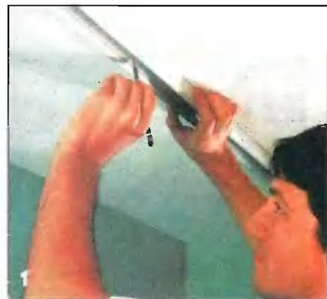
Используя направляющую шину для раздвижных дверок, размечают места крепления потолочных элементов.
