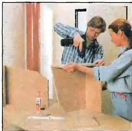
Короба, на которые будут монтироваться сегменты круга, собирают на клею и шурупах.
