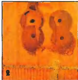
2 Дополнительно, пользуясь зубилом и молотком, слегка расширяют кабельные вводы.
