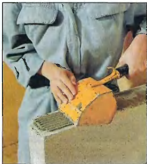
Раствор наносят тонким слоем, что позволяет уложить блоки почти вплотную друг к другу.
