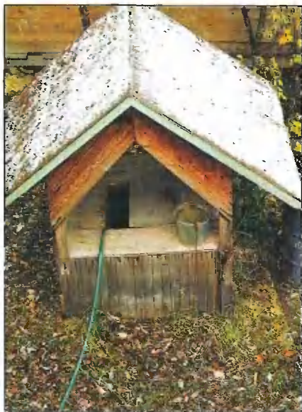
Источником круглогодичного водоснабжения является имеющийся на участке колодец, заполняемый грунтовой водой.
