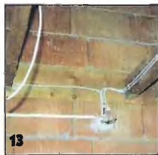
13 По деревянным конструкциям и в полостях следует прокладывать только кабели с защитной оболочкой.
