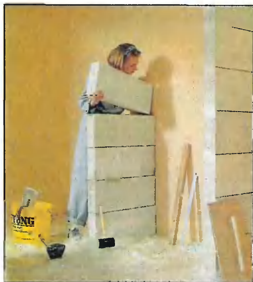
Блоки кладут один на другой на растворе и для устойчивости скрепляют со стеной.
