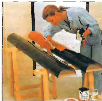
Для хорошей адгезии краски и уменьшения количества слоёв пластиковые трубы сначала грунтуют.
