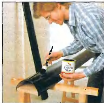
После высыхания грунтовки наносят слой краски. Одного её слоя достаточно, так как грунтовка и краска одного цвета.
