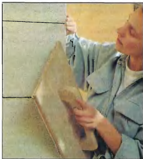
Мелкие неровности можно сгладить с помощью крупной шлифовальной шкурки, прибитой к соколу, тёрке или обрезку доски.
