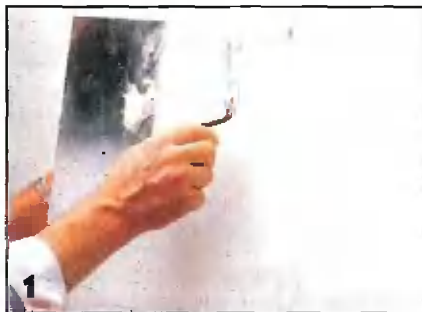
Сначала шпательюют трещины и неровности на стенах.
